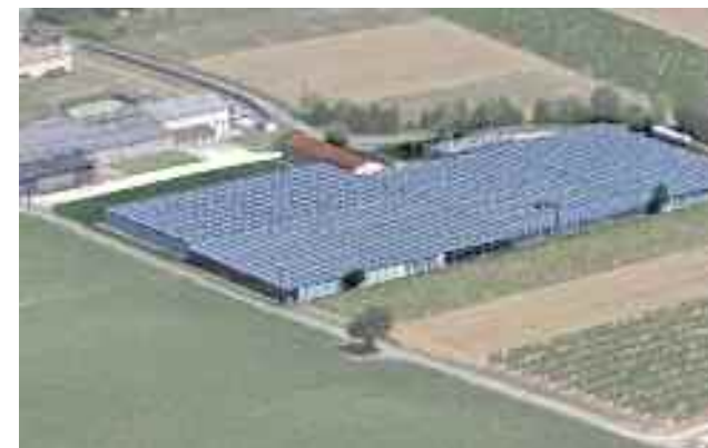
LES TOUCHES DE PÉRIGNY (1,2 ha de Serre chauffé par récupération d'eau chaude)
